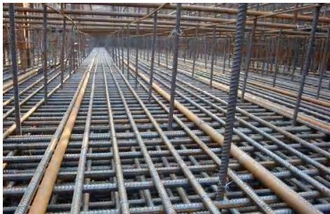
图 8.2 混凝土冷却管布置
